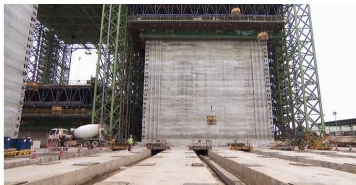
Travaux de construction du port de Tuas Megaport
